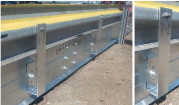
**Bild 6:** Anbringung des UFS mit zweiteiligen Bügeln
