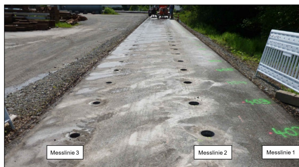
Bild 3: Beprobung der Messlinien der 2 000 MHz Radarantenne mittels Bohrkernen im 1-m-Raster
