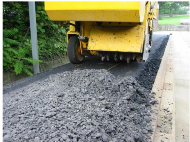
Bild 2: Fräsen der eingebauten Schicht
