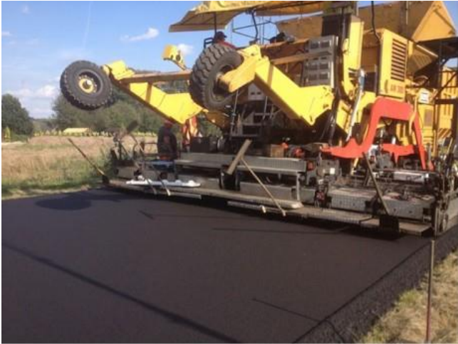
Bild 19: Einbau mit modifizierter Kompaktasphaltbauweise an der Versuchsstrecke B 68
