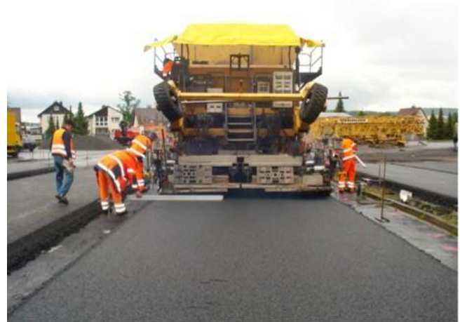
Bild 10: Deckschicht von Versuchsfeld 3 (mod. Kompaktasphalt 22+2 cm) vor der Walzverdichtung
