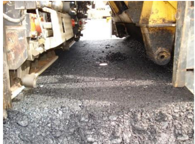
Bild 9: Oberfläche der Binder-/Tragschicht von Versuchsfeld 3 (mod. Kompaktasphalt 22+2 cm) vor der Deckschichtbohle
