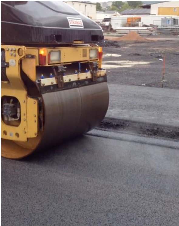
Bild 11: erhöhtes Einsenkmaß bei dynamischem Walzübergang am modifizierten Kompaktasphalt
