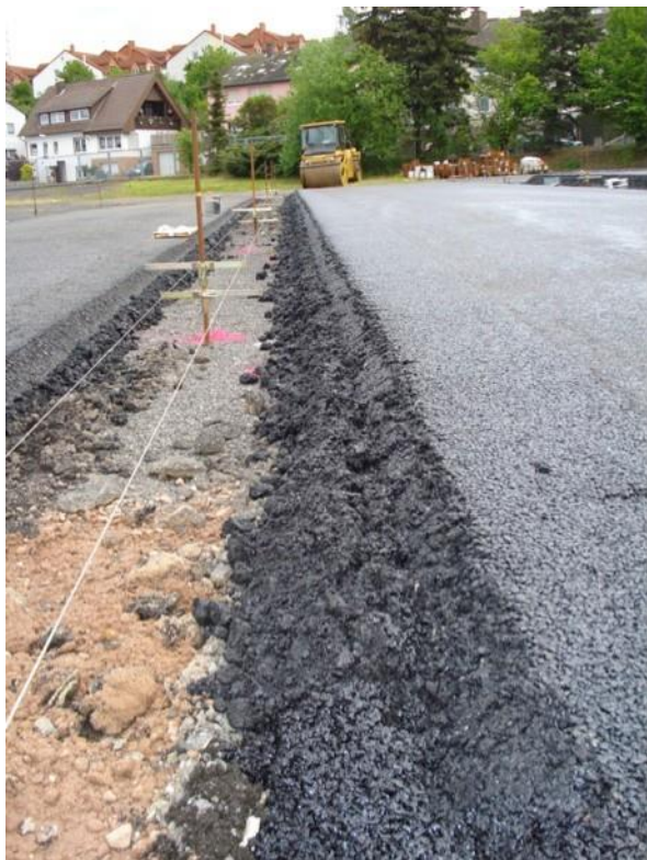
Bild 12: ungleichmäßiges Kantenbild an den dicken Kompaktasphaltaufbauten (rechts) ggü. typischer Kantenverdichtung am 12 cm – Referenzfeld (links)
