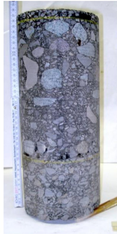
Bild 13: Bohrkern aus Versuchsfeld 3 (mod. Kompaktasphalt 22+2 cm auf geb. Unterlage)
