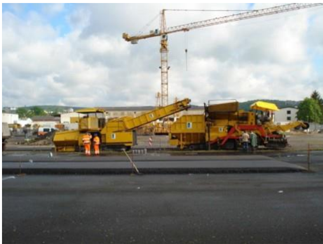
Bild 8: Einbau der Versuchsfelder
