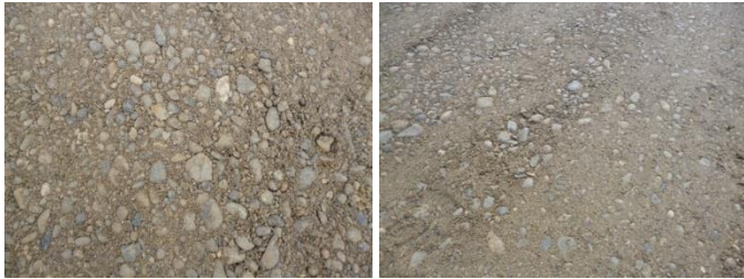
Bild 2 und 3: Oberfläche der modifizierten Kiestragschicht direkt nach dem Einbau (links) sowie nach 16 Tagen freier Witterung und Baustellenverkehr (rechts)
