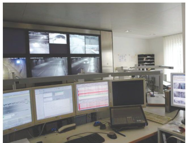
Bild 2: Integration der Kamerabilder in die Arbeitsumgebung einer Leitzentrale
