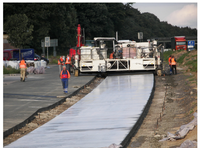
Bild 4: Versuchsstrecke in der Bauphase
