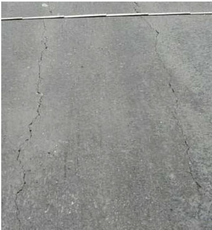
**Bild 1:** Risse in einer Betonfahrbahndecke im Bereich von Rüttelgassen
